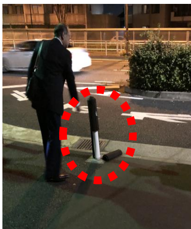
〈修理前/鉄柱がむき出しです〉
