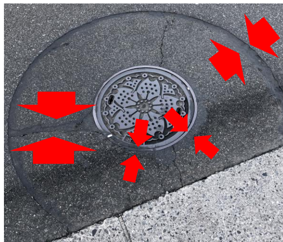
〈補修後/振動が収まりました〉
